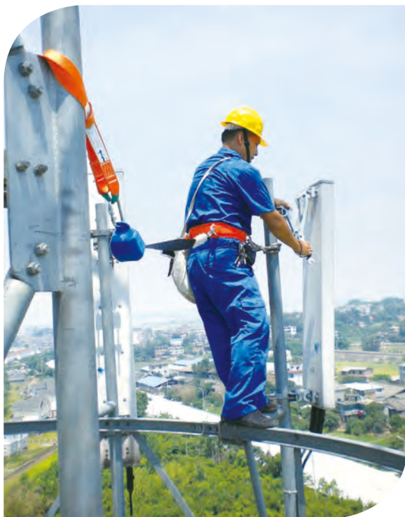
本集團承接4G建設工程
