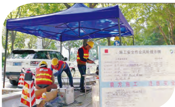
光纜網絡搶修工程
