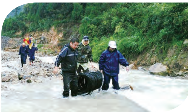
災後基站搶修
