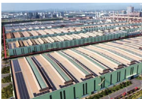
● 青島某鋼鐵公司分佈式屋頂光伏項目
