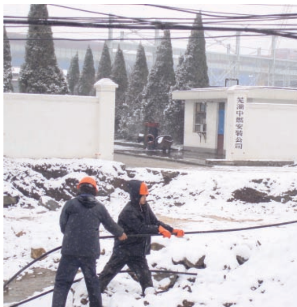
管線工程施工
