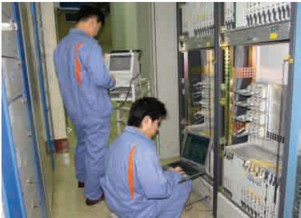
為廣州白雲機場機房調測傳輸設備
