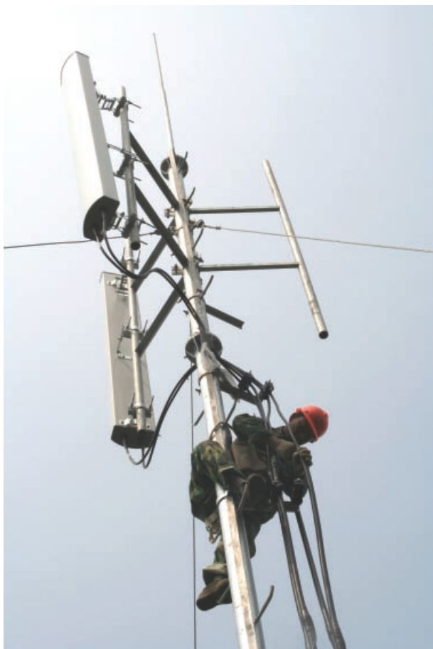
移動機站建設
