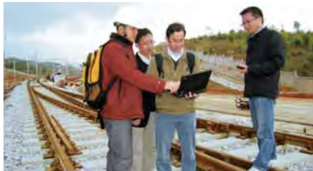
◎ 設計人員在武漢—廣州高速鐵路進行無線通信測量
