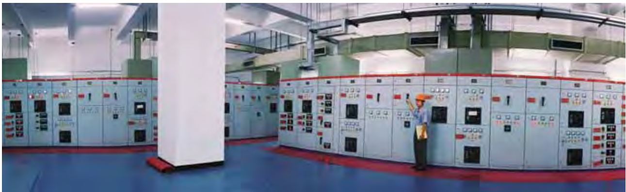
◎ 設備安裝效果檢查
