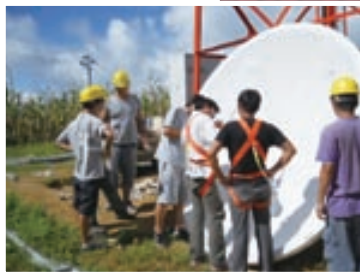
■ 海外工程現場
