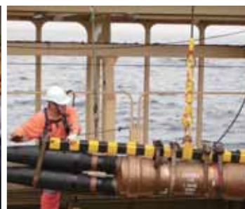
海底光纜工程
