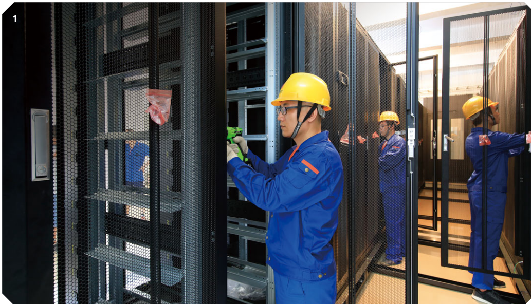
1. 本集團承接 IDC 數據中心項目
