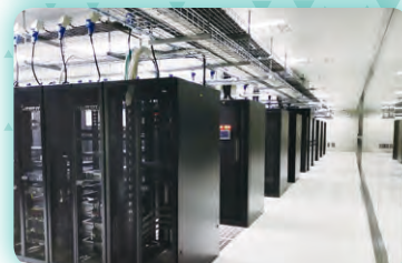
本集團積極承接數據中心項目建設
