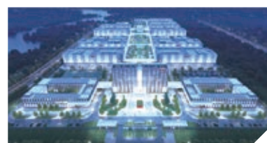
● 某頭部保險公司西部數據中心一期項目
