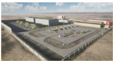
◆ 某縣燃氣及安全預警建設項目
