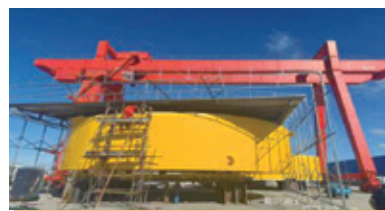
◆ 某海底數據機房工程建設項目
